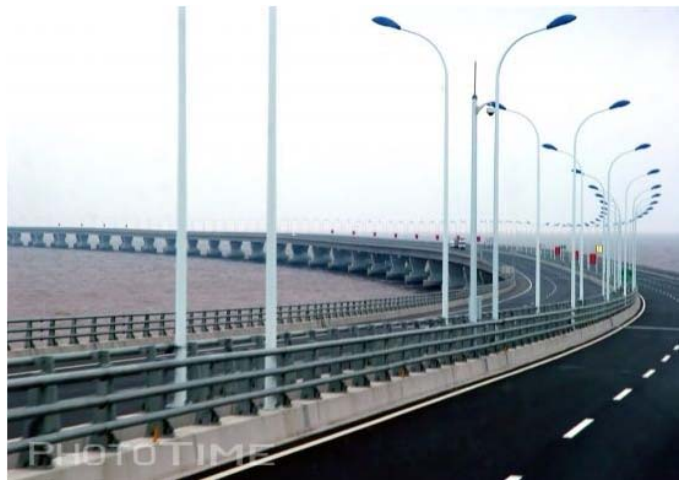
东海大桥的应用
